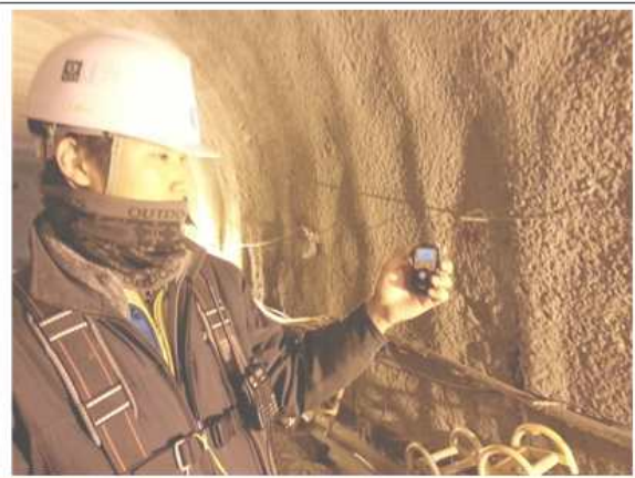
터널 내 공기 측정
