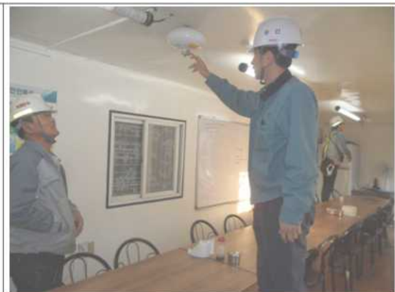
자동 확산 소화기 설치
