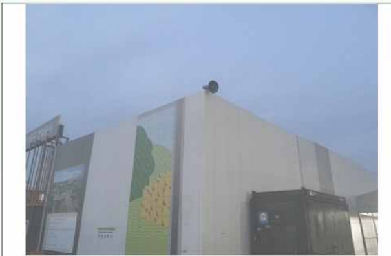
발파 시 주민대피 확성기 설치
