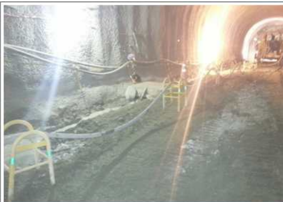
스탠드 형 전선 거치대 설치
