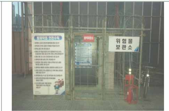
화약창고 저장소 설치
