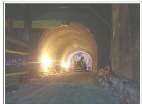
터널 내 조명 설치
