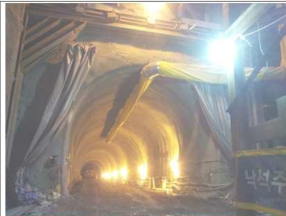
환기 시설 설치
